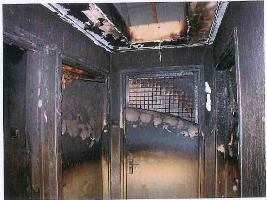
A-2.11: afbladderende verflagen...
