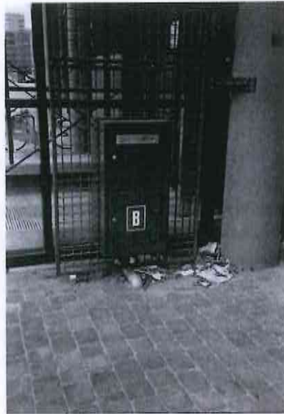
D-1.3: aansluiting droge blusleiding op straatniveau
